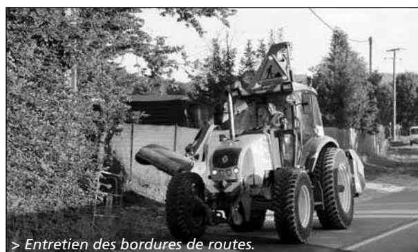
> Remise en état de la voirie communale avec la CAPV.
