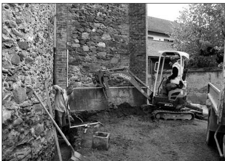
> Restauration fondation église
