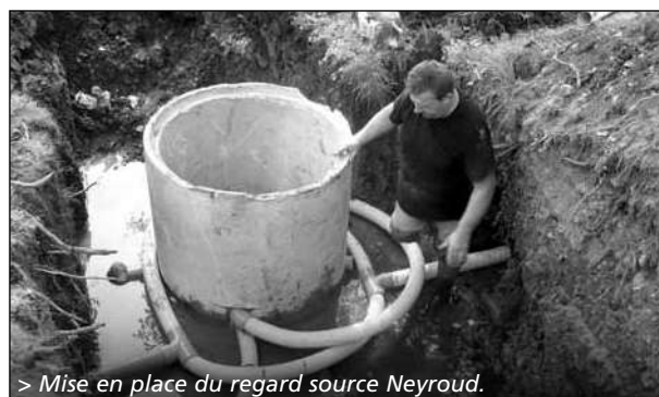
> Réfection captage source Neyroud.
