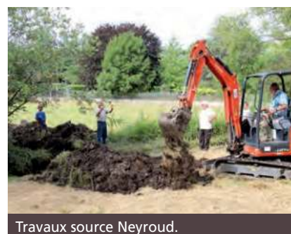
Travaux source Neyroud.
