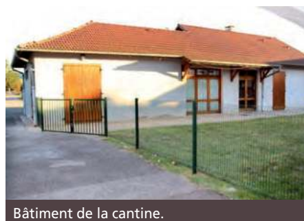
Bâtiment de la cantine.
