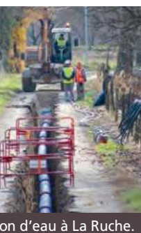
Travaux d'eau à La Ruche.
