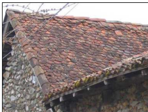
Photo 51 : Tuiles écailles et plates, rouge vieilli ; mur en galets
