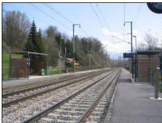
Photo 4 : Quais de la gare de Réaumont / Saint-Cassien
