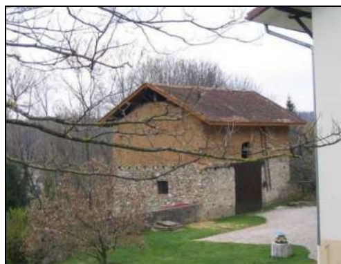
Photo 52 : Toiture en tuiles, façade en galets et pisé
