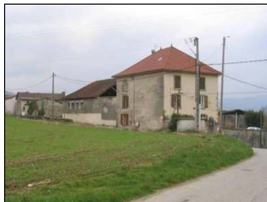
Photo 52 : Toiture en tuiles, façade en galets et pisé
