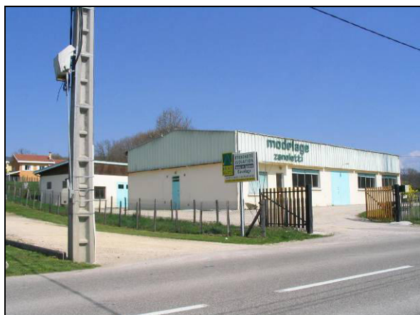
Photo 9 : Bâtiment d'activité le long de la RD 12
